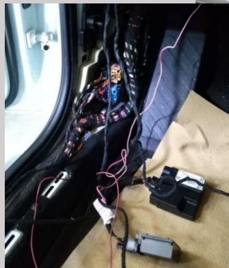
Verkabelung des Steuergeräts im Sicherungskasten
